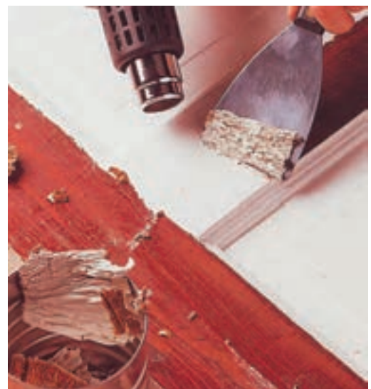
شکل ۱۲-۱۱- برداشتن رنگ به روش حرارتی.
